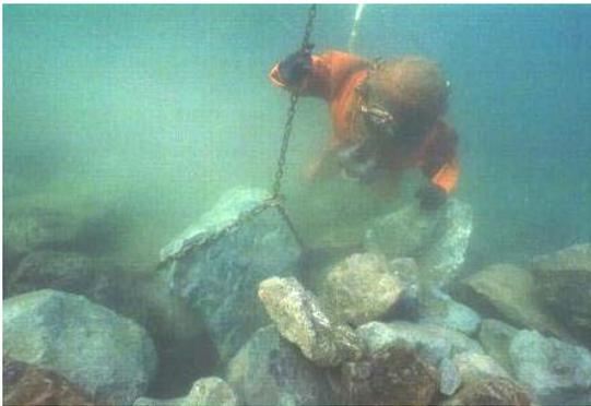
図-1 潜水士による水中均し作業
