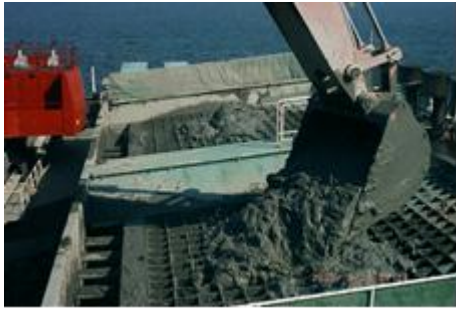
図－1 港湾工事で発生する浚渫泥土
