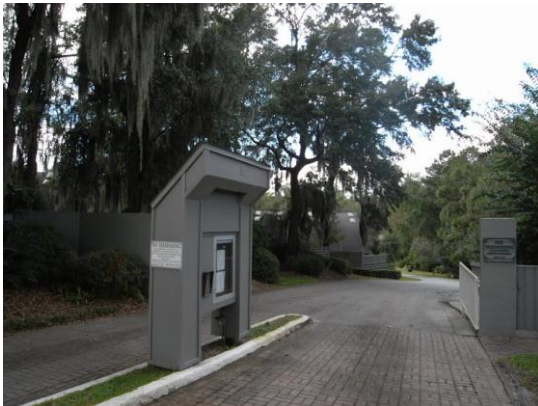
開放されたままのゲート
