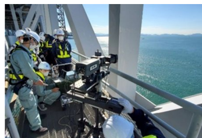
図6 長大鋼橋におけるハイパースペクトル計測
