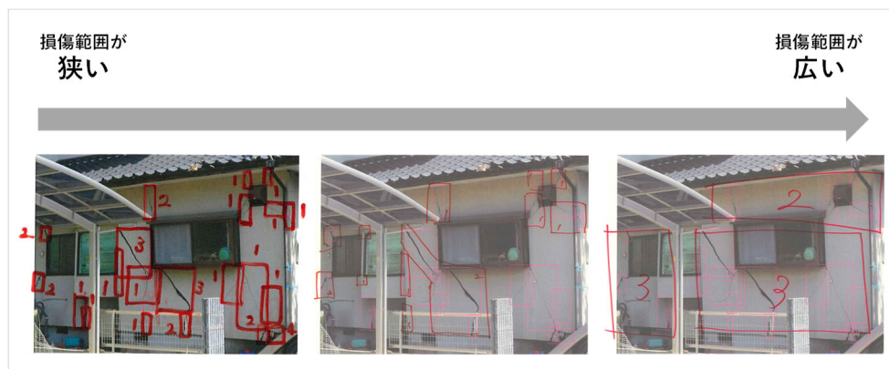
図1 調査員による損傷認識の範囲の違い
