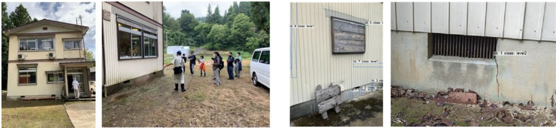
図6 実建物を利用した実証実験の様子（左）とシステムの判別結果（右）
