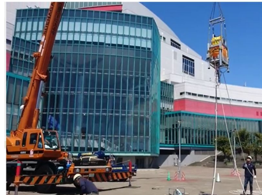
タンクを 30m クレーンで吊り上げている様子
