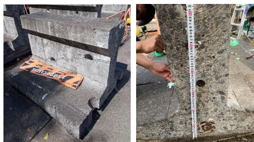
図-3 供試体 C の外観
