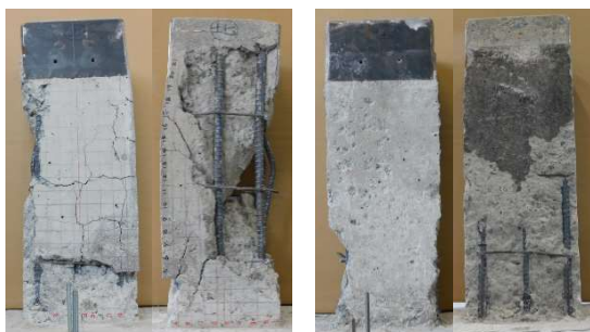
(a) 損傷 RC 柱 1 (b) 損傷 RC 柱 2 写真1 損傷 RC 柱の状況写真
