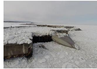
図1 複数貫通孔、内部空洞化後、海水衝突で崩壊（オホーツク沿岸導流堤）
