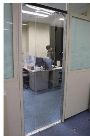
図 5：試作した実物大プレナムドア
