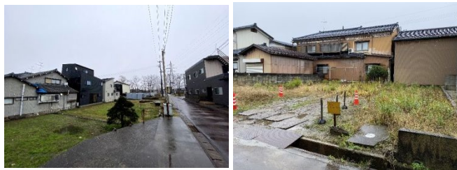
図7 燕市で発生した大規模火災の復興状況
