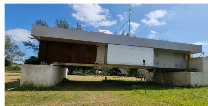
図 3 3D レーザースキャナでの計測状況
