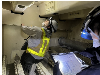
図 13 デジタル点検野帳での点検状況
