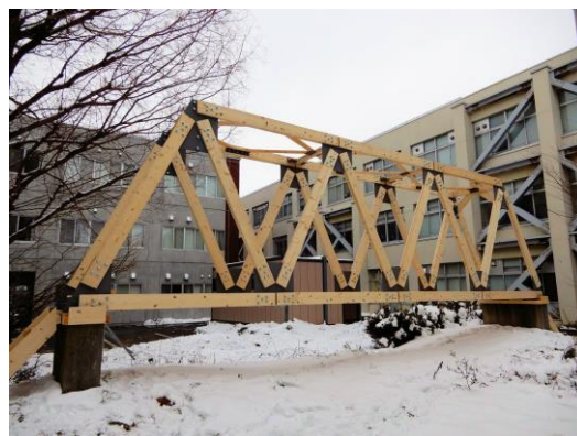
写真-1 2×8材を用いたトラス橋(2019年)
