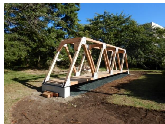
写真-7 屋外での完成写真
