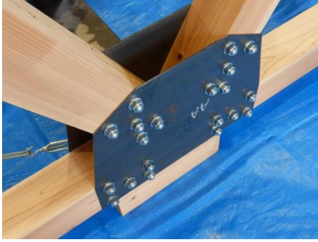
写真-2 中間部のトラス部材接合部
