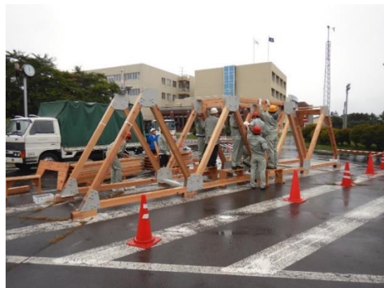
写真-5 屋外での組み立て作業
