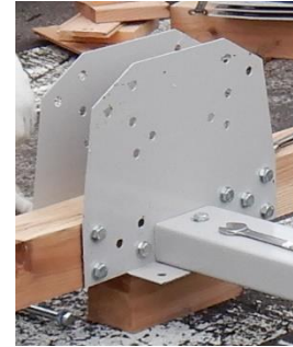
図-1 本研究で考案した横梁の接合
