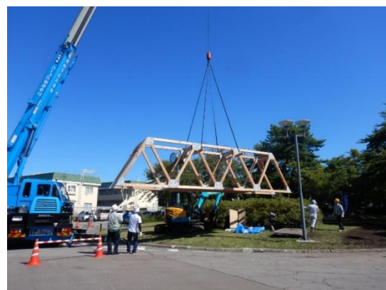
写真-6 クレーン一括架設
