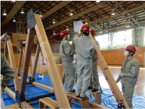
写真-4 屋内での組み立て作業
