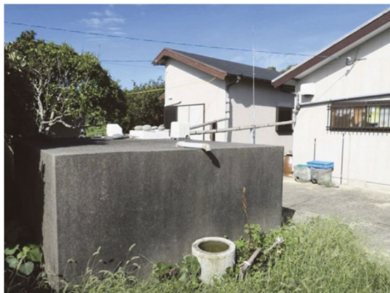
図 2. 赤島の各家屋に設置されている雨水貯留タンク
