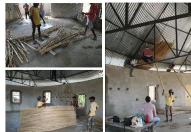
写真 5：茅葺パネルのモックアップ
