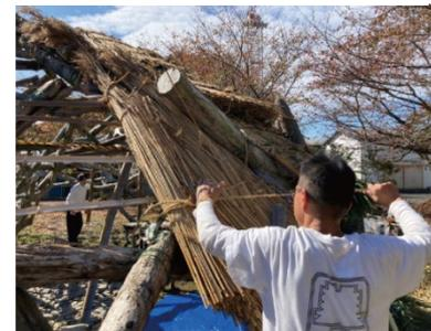
写真7：ヨシを躯体に結び付ける
