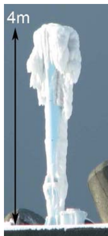
図 1 小型防波堤灯台の着氷例。
