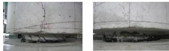
a)No.3 (挿入部補強なし) b)No.4 (鋼管補強)
