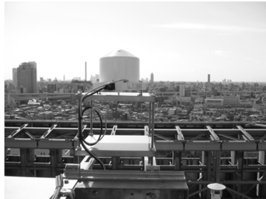
図1 赤外放射計の設置状況
