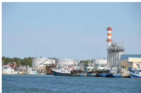
図4 ブロラ火力発電所
