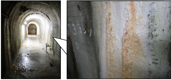
写真-7 監査廊内部 (その1)
