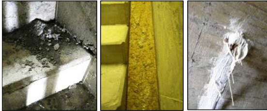
写真-8 監査廊内部 (その2)
