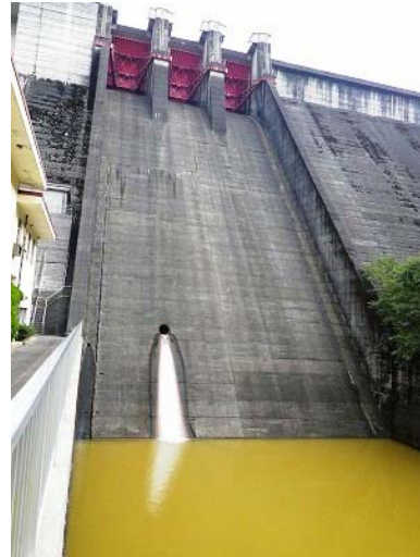
写真-5 ダム提体下流側の越流部および減勢工
