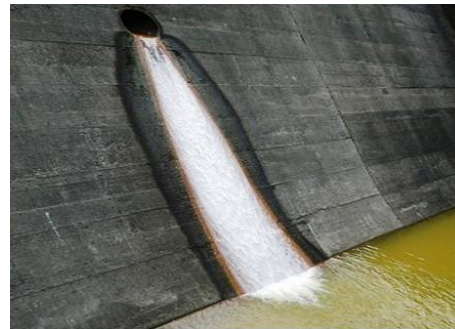
写真-6 ダム提体下流面に排出されるダム湖水
