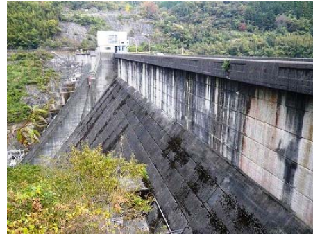
写真-4 ダム提体下流面
