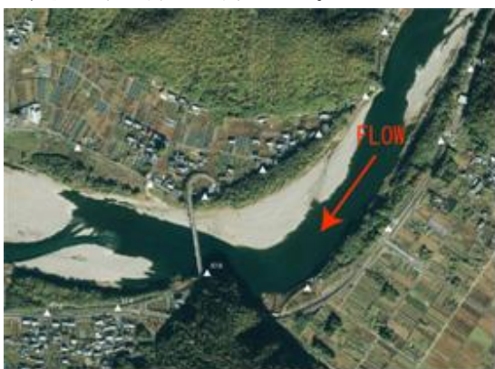
写真1 長良川千鳥橋空中写真
