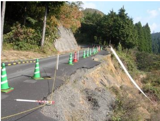
図 1.1 道路の崩落
