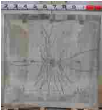
図-8 実験時のひび割れ
