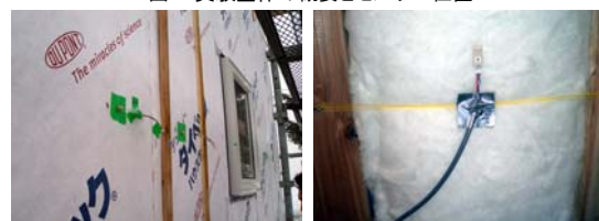
写真 1-2 壁体内へのセンサー設置状況
