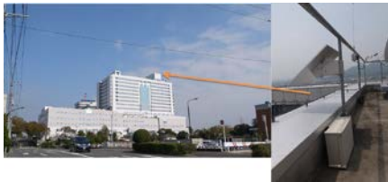
図3 約75m 高の病院の屋上に設置
