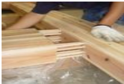
写真2 木ダボを用いた GIR 接合法 (秋田県立大学)
