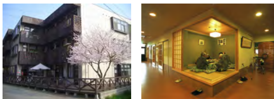
図 1. 調査対象施設の外観と内部共用空間
