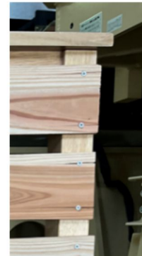
(b) 健全試験体におけるラスの固定
