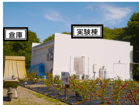
図1. 岐阜大学教育学部ダブルハイパー核実験棟および倉庫。
