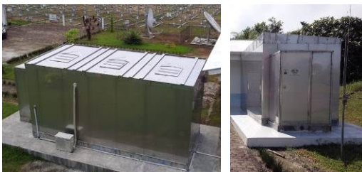
図 5 オゾンライダー観測棟
