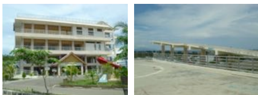
図4 バンダ・アチェの津波避難ビルと落書のある屋上
