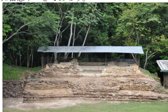
写真 4 建造物 6 正面 (東面) の仮修復
