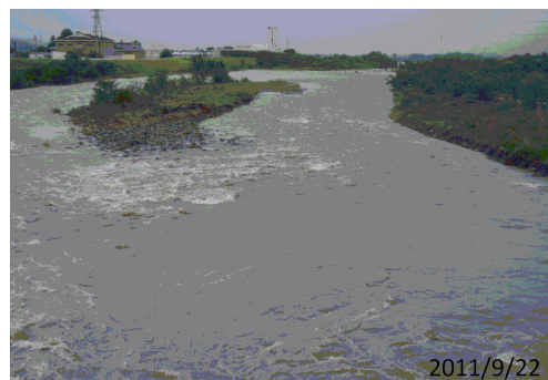
図 5 昭和橋下流の掘削路の拡大
