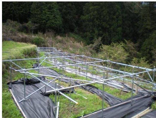
写真4 棚田テラス面に設営中の施設
