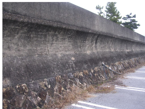
写真1 有明海沿岸部の旧干拓堤防に残る堤防嵩上げの痕跡
