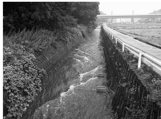
図2 コンクリート3面張り工法による水際のエコトーン機能が著しく消失地点での小規模な自然再生手法の導入実験の例（池尻川・増水時の様子）
