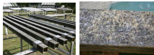
図-6 黒色汚れ状の変状(供試体 No.3A, つくば)
