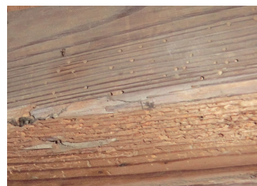
図2 角屋床下部材のシバンムシ被害
