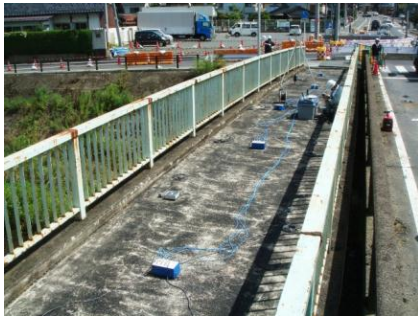
図1 計測対象橋梁
