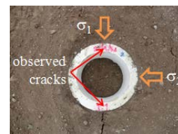
観察された亀裂
