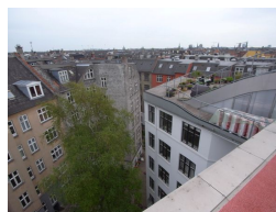
写真 5. 事例 D. 住宅協同組合主導の既存集合住宅再編プロジェクト（写真右手の住棟）。屋上に 3 戸増築するとともに、コミュニティのための屋上庭園などを整備した
