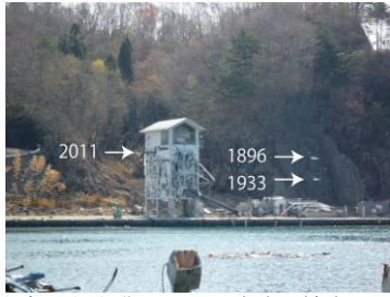
図7 宮古市田老漁港における津波の被害と明治・昭和の三陸津波の高さを示す表示板。
