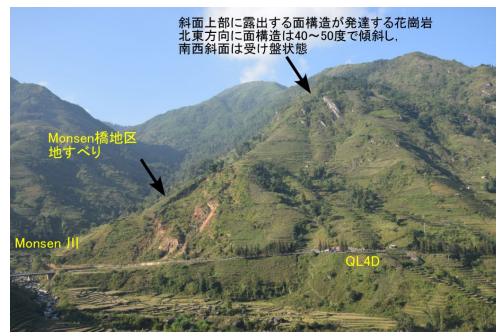
図2 モンセン橋地区の地すべり。
