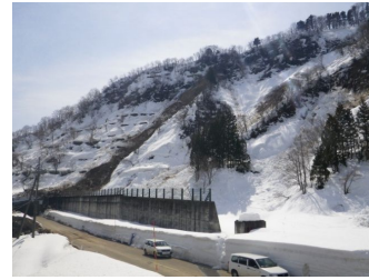
図 1 地震崩壊斜面における雪崩発生
