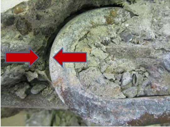
図-6 主鉄筋の重ね継手部のすべり
