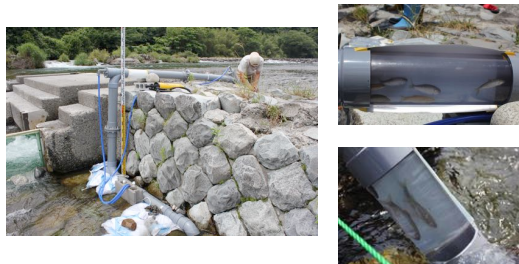
図-1 現地河川のパイプ魚道の設置例
