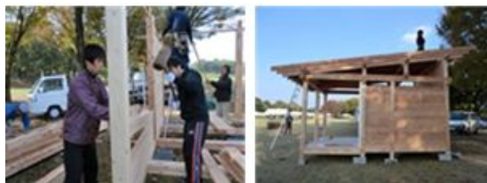
図4 伝統構法による仮設住宅の施工実験
