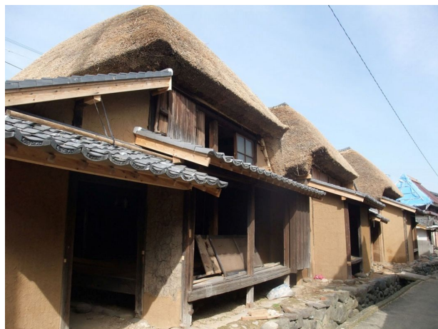
図1 肥前浜宿の町並み(庄金地区)
