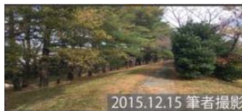
写真4 広村堤防の天端の様子
