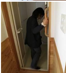
写真4 左：浴室入口の様子 右：追加の縦手すり
